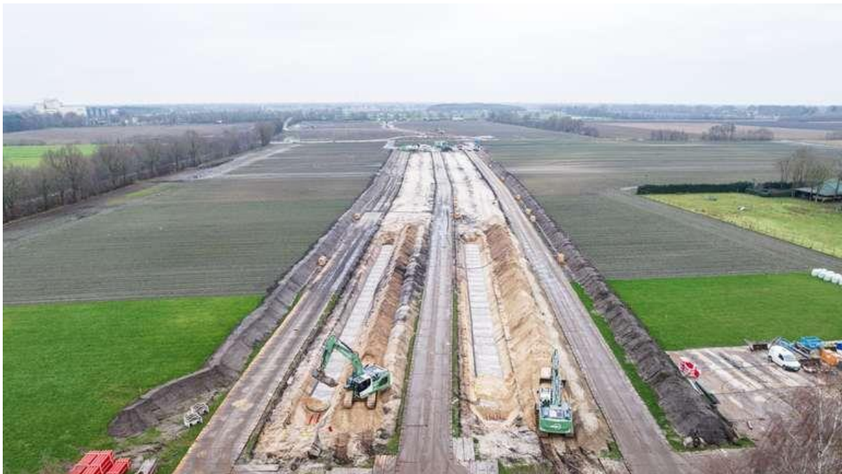
Abbildung 4: Kabelverlegung in offener Bauweise 2
